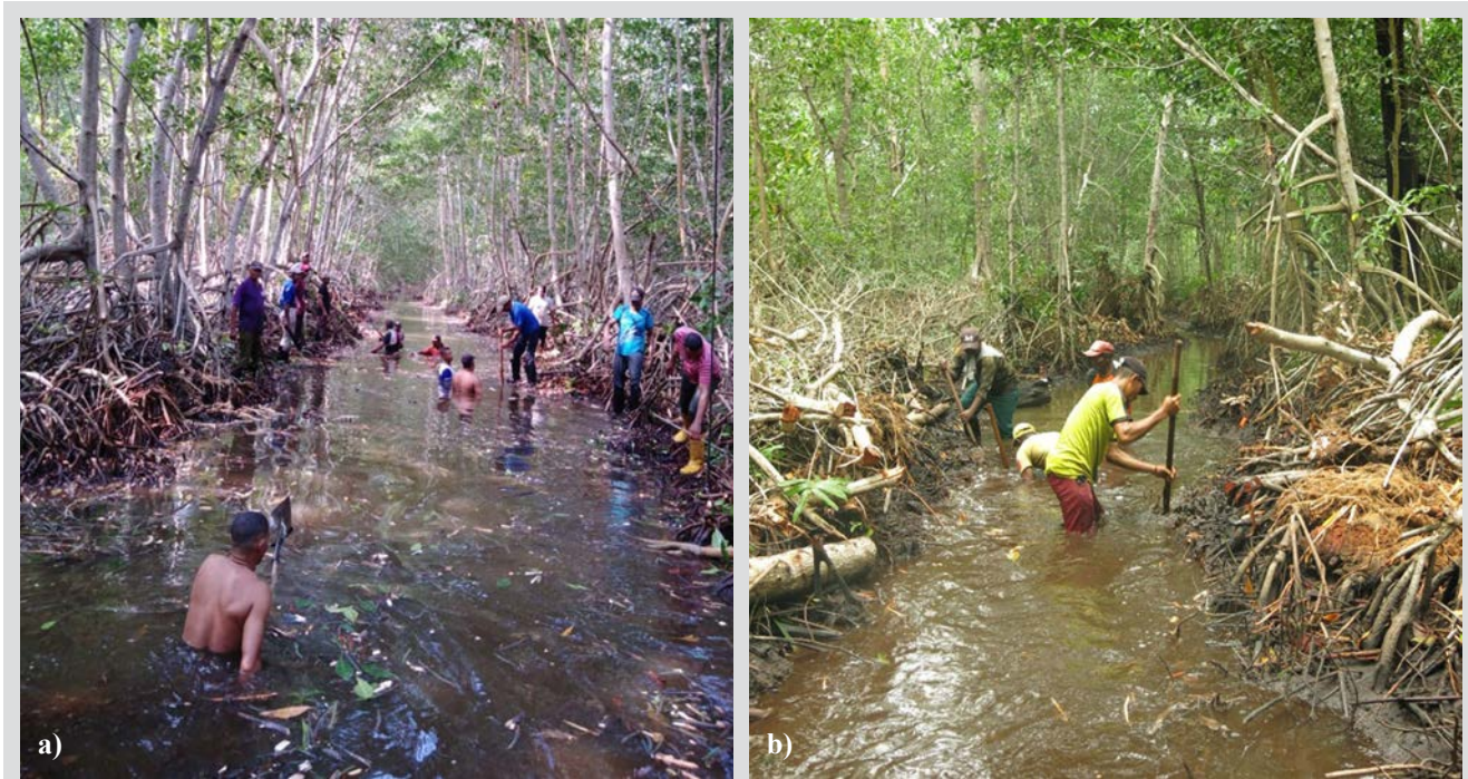
Figura 2. Rehabilitación de los Caños Dago a) y Ustria 1 b) en el DMI Cispatá. Fotos: ASOMAPESCA e Invemar.
