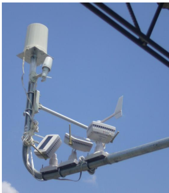
Figura 1: Estación meteorológica WMR-968 sobre un brazo metálico fijo que fue instalado en una de las vigas de techo de la escuela.
