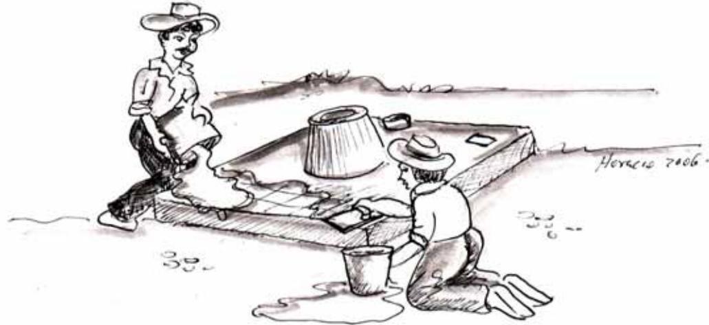
**FIGURA No. 3.4** La losa o piso de la letrina debe tener la misma forma y tamaño de la base, colocando la taza en el centro.
