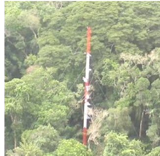
Torre de monitoreo en los terrenos de la Universidad Tecnológica
