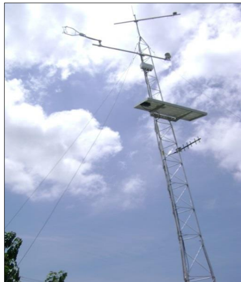
Figura 1. Estación Tocumen. Fuente: CIHH.
